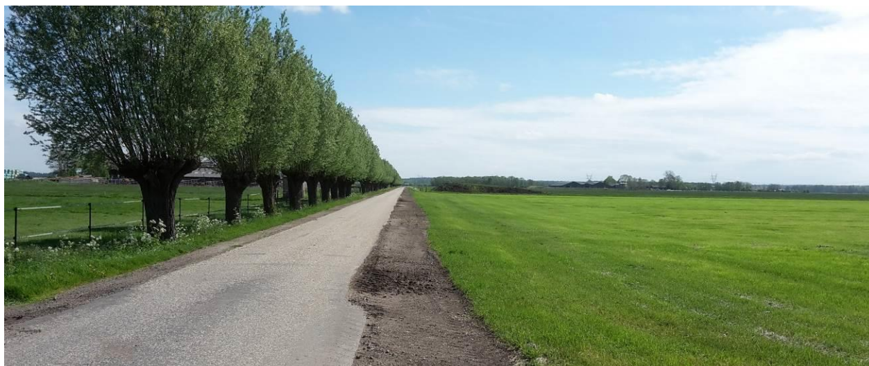
Demping van bermsloot langs landbouwweg in de polder Laag Zalk in 2018. De bermsloot en deel van de berm is bij het landbouwbedrijf aangetrokken (gemeente Kampen).
