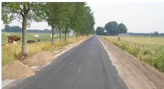
De Doorlopende dijk binnen de gemeente Holten-Rijssen in 2006 met wegwerkzaamheden.
