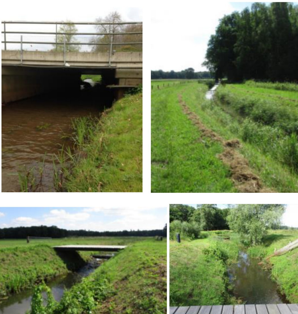
Figuur 3-9 Impressie Hammerwetering: brug Hammerweg (linksboven), bij bos en brug wandelpad (rechtsboven), nabij de Reggemonding (rechtsonder) met vaste drempel (streeppeil 3,73 m+NAP) en stenige beekloop (rechtsonder). (Royal HaskoningDHV, 9 juli 2017)
