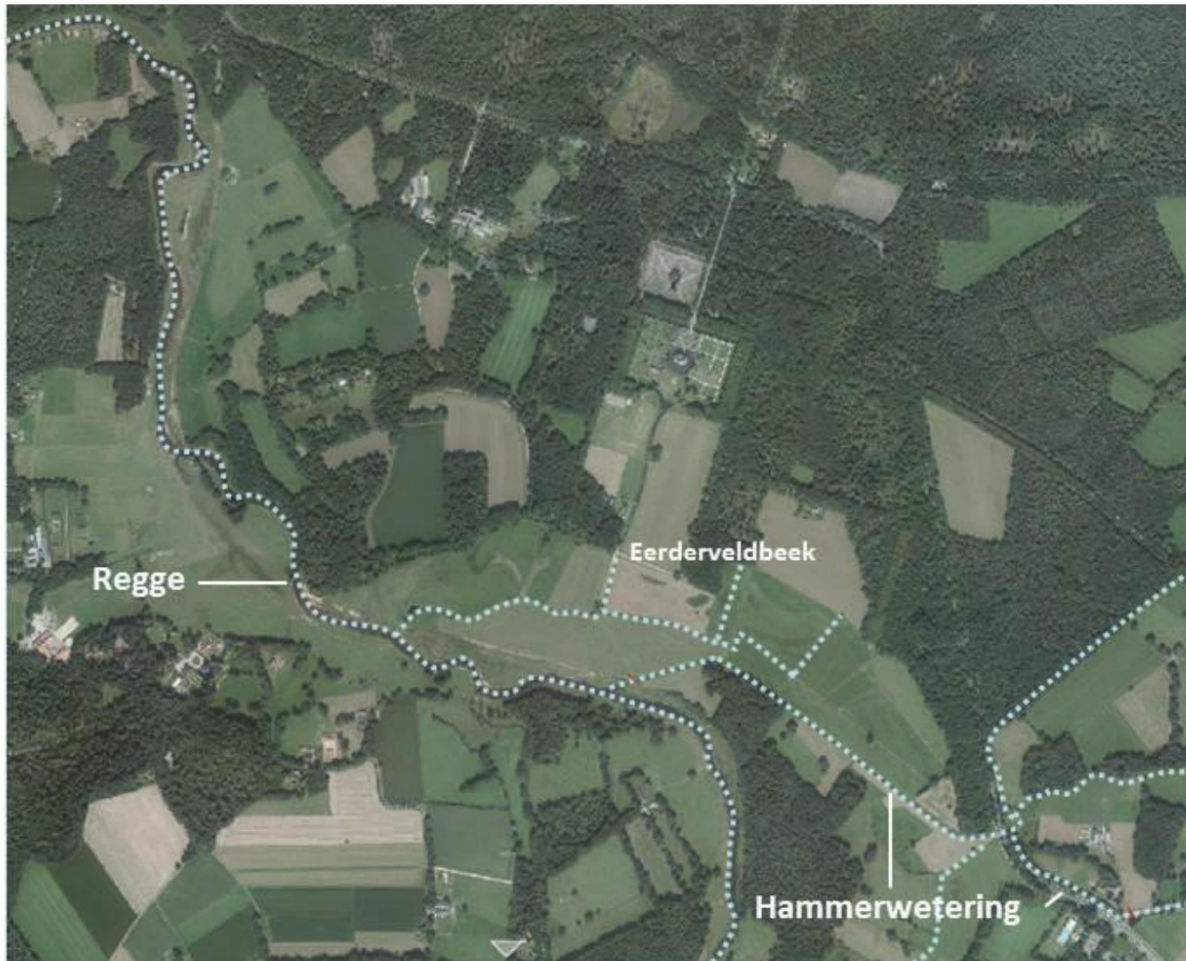
Figuur 3-18 Waterlopen met beheer waterkwantiteit en- kwaliteit (Wateratlas, 2018). De Regge en Hammerwetering zijn in beheer van waterschap Vechtstromen; de Eerderveldbeek is in beheer van aangrenzende terreineigenaren/gebruikers. (Bron ondergrond: luchtfoto 2017 Globespotter Cyclomedia)
